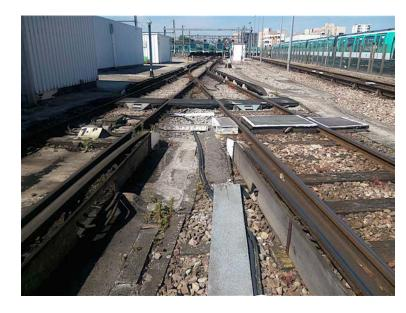
Le cheminement, entre la voie U et la voie P, a été immédiatement interdit. La direction a sorti une note (avec photo) à destination des conducteurs et conductrices pour expliquer cette interdiction. Sur la voie RD, les dalles de cheminement ont été réparées et le tabouret de voie va être installé prochainement.
