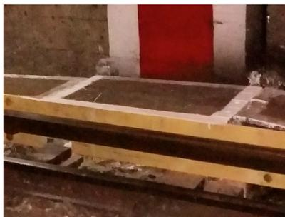
Le 31 mai 2017, SOLIDAIRES a déposé un droit d'alerte du CHSCT pour risque de chute, d'écrasement et d'électrification lors de l'accès au rupteur 4-36, situé en entrée d'Invalides quai 4. Le cheminement surélevé était collé au rail de courant (750v). L'accès au rupteur est dorénavant protégé par une planche lorraine qui est plus haute que le cheminement et qui sépare la plateforme du rail de contact.
